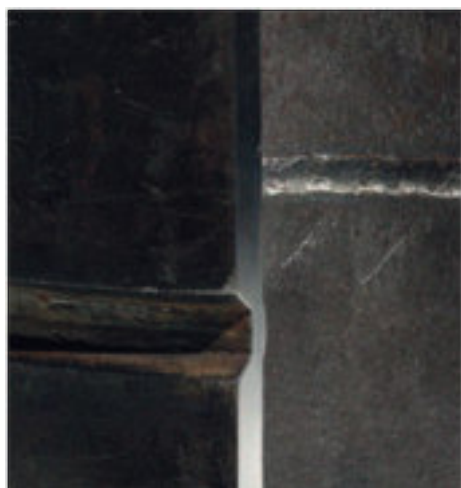
Сварка металлическим электродом в инертном газе с системой уменьшения налипания брызг - Первый проход на трубе с разделкой кромок.
