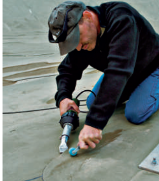
Сварка внахлест кровельной мембраны при помощи TRIAC AT и щелевой насадки
