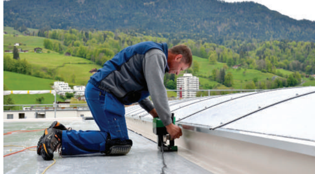
Сбоку или сверху парапета, для сварки мансардных окон, соединений или небольших террас — UNIDRIVE 500 впечатляет даже в условиях ограниченного пространства
