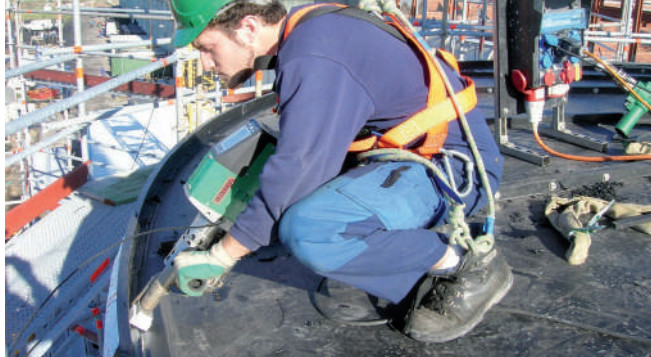
Мощный Weldplast S4 в работе
