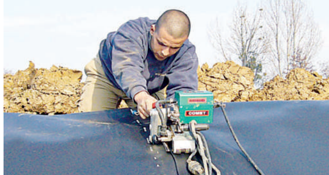
... на обустройстве полигона
