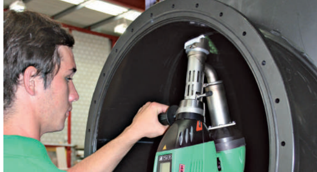
Легко сваривать даже внутри труб
