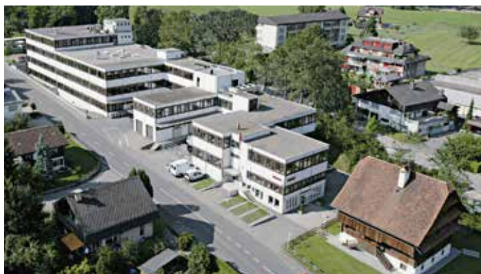
Leister Technologies AG, производственное здание, Кегисвиль, Швейцария
