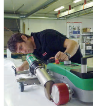
Простая сварка с подворотом и кедером при использовании специального комплекта
