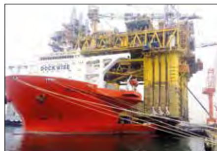
Синхронный монтаж конструкций и спуск их на воду
