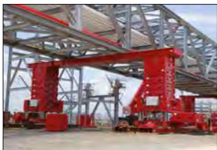
Циклическая навдвижка мостов
