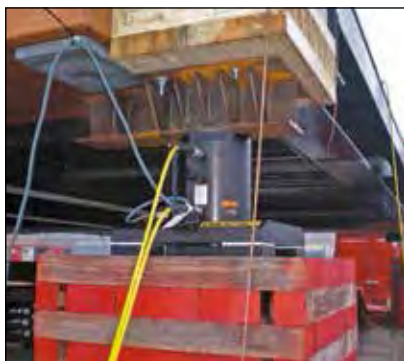
◀ Пример работ по ступенчатому подъему с применением выполненной на заказ подъемной системы Enerpac - подъем 360-тонного деревянного моста Akkerwinde в Нидерландах.
