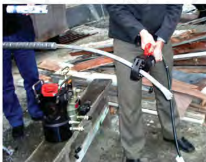
Резка провода АС-300/39 универсальным неавтономным резак SP-32
