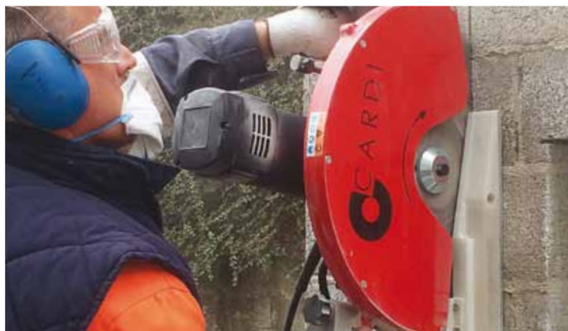
Резка железобетона без использования воды
