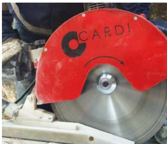
Резка железобетона «в сухую»
