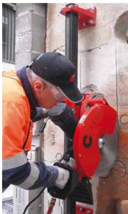
Вертикальный рез бетонной стены
